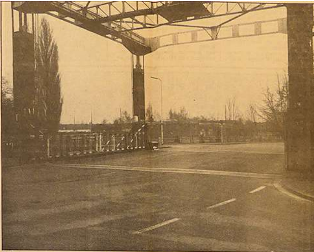
• De brug aan de Tongelresestraat, met op de achtergrond het gildeterrein.
